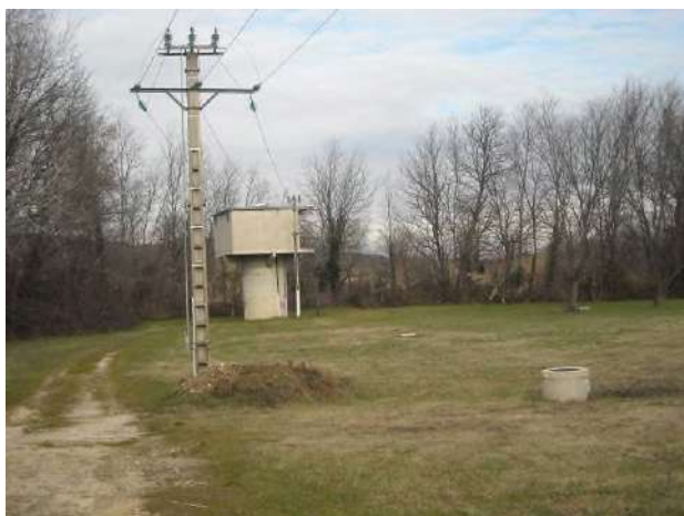
Le Puits de la « Croix de Fer » et son local commande dans la partie haute de cet ouvrage de captage.
