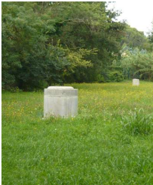
Photographie n°4 : Regard d'exploitation du forage F3
