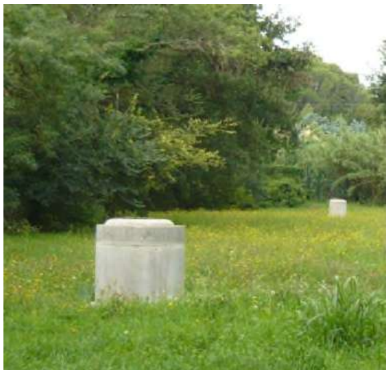
Regard d'exploitation du forage F3
